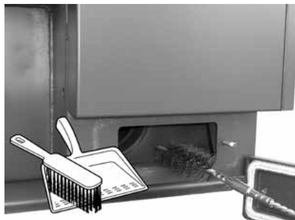
Пример очистки дымовых способом - снизу крышка
